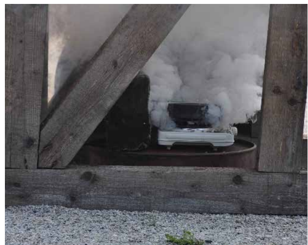
Beispiel eines Batteriebrandes und der starken Rauchentwicklung
