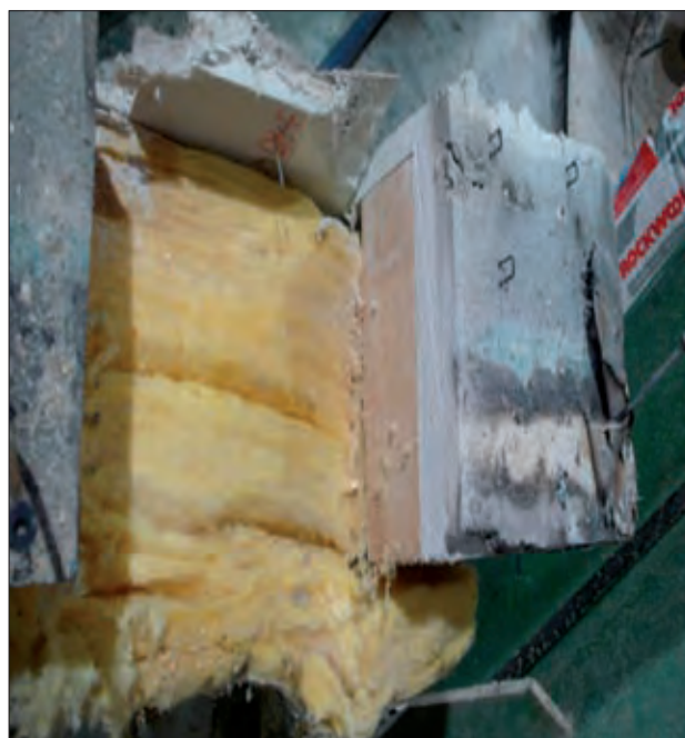
Abbildung 8: Unversehrtes Konstruktionsholz nach der Prüfung
