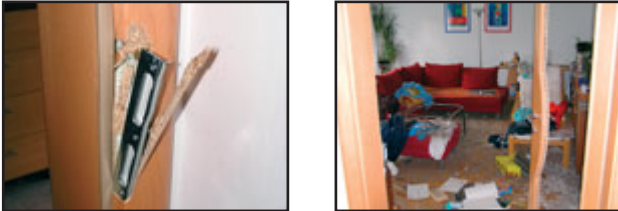
Abbildung 3: Aus dem Schloss gerissene Wohnzimmertüre
