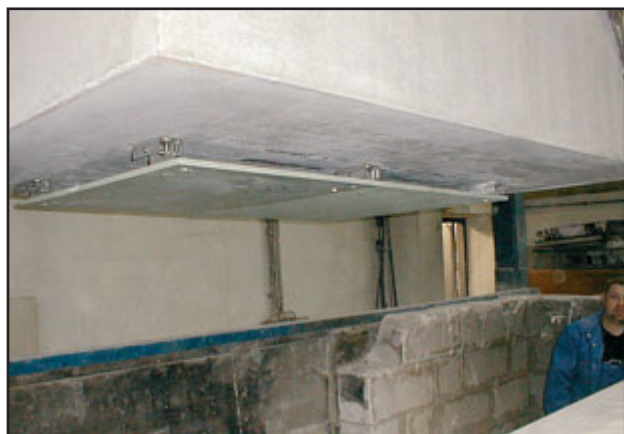
Abbildung 12: Fertig aufgebrachte Platten
