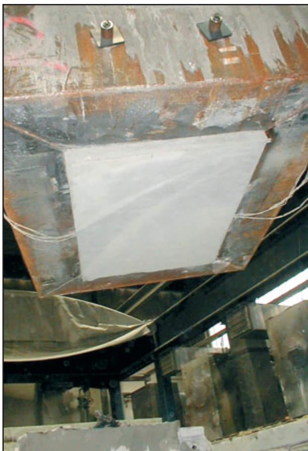
Abbildung 9: Schutzschicht unmittelbar vor dem Brandversuch
