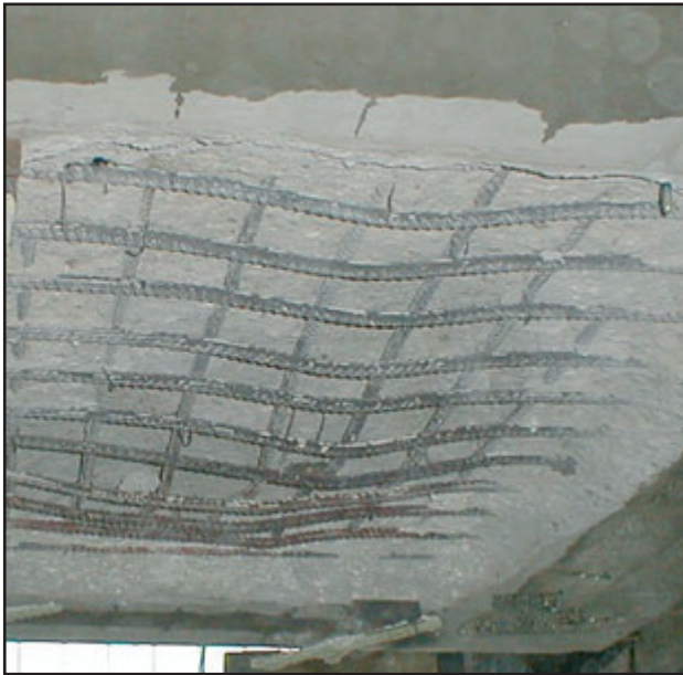
Abbildung 2: Betonabplatzungen bei Normalbeton nach Beanspruchung mit der RWS-Kurve, 45 Minuten
