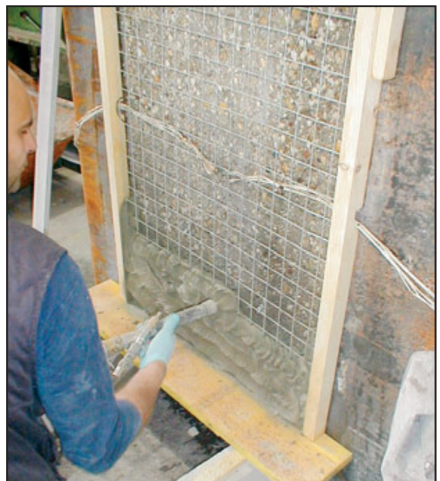
Abbildung 7: Aufbringen der Schutzschicht
