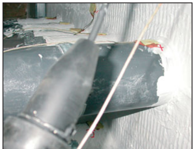
Abschottung von brennbaren Rohren bis Ø 160 mm im Weichschott mittels Brandschutzband CP648 E oder S.
