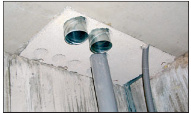
Mögliches Einsatzgebiet Hilti Brandschutzband: Abschottung von brennbarem Abwasserrohr im Protteolith-Installationsblock im Steigschacht.
