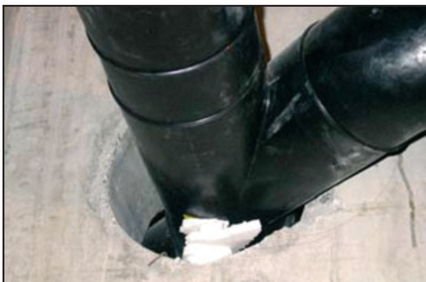
Hilti Brandschutzband in 10-Meter-Rolle (CP648E) oder als abgelängter Brand-schutzstreifen (CP648S).
