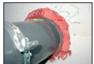
Rohrabschottung mit Hilti Brandschutz-band CP648; Fugen-abschluss mit Brand-schutzschaum CP620.
