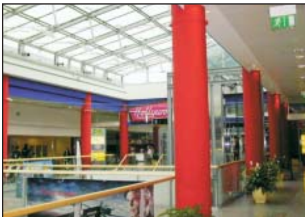
Abb. 4: Rauchschürze an Deckendurchbruch zur Mall
